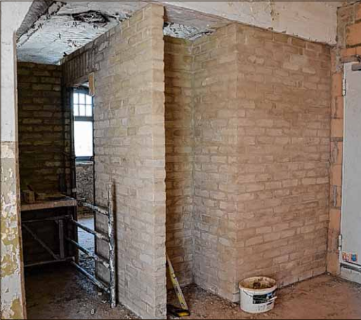
Ein Wohnungseingangsbereich: Direkt hinter der Tür schließt sich eine neue Mauer aus alten Steinen an. Die gemauerte Nische ist die Garderobe.
