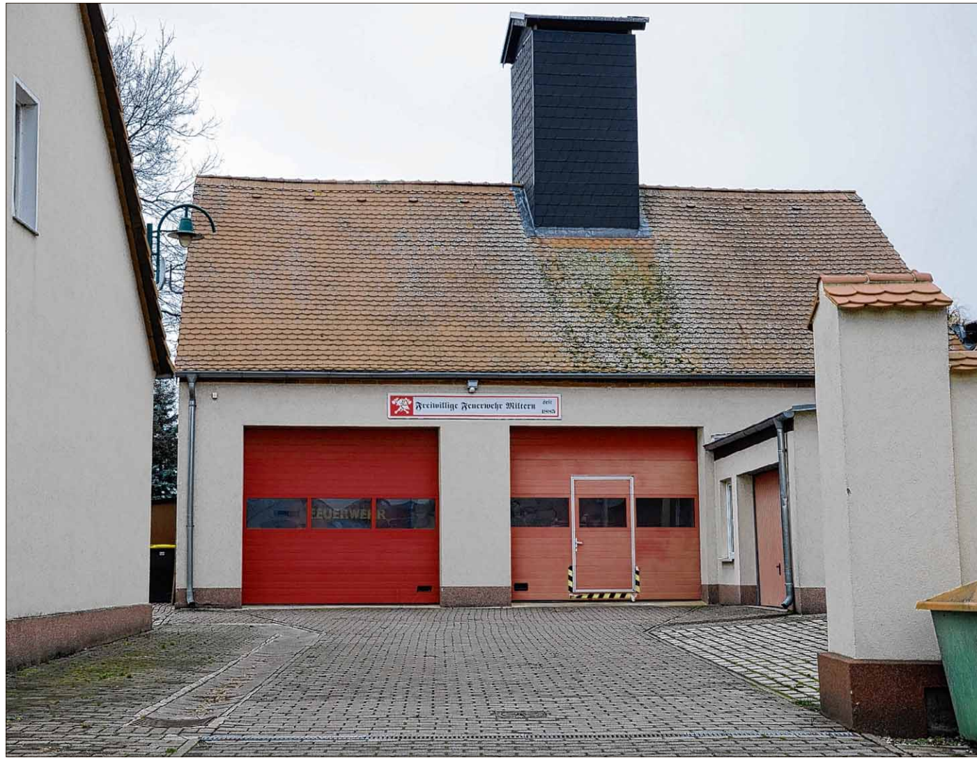
Das Feuerwehrgerätehaus von Miltern: Noch vor der Gemeindegebietsreform hatten die Kameraden selbst hier kräftig angepackt, um mehr Platz für die Technik, die Kleidung und alle erforderlichen Utensilien zu schaffen. Foto: Anke Hoffmeister
